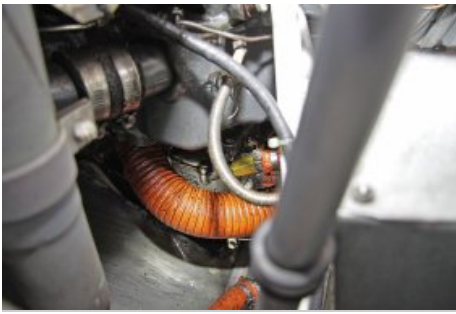
Ein Blick unter die Cowling verrät schnell, ob irgendwo etwas undicht ist. Die vielen Ölspritzer auf dem Schlauch deuten auf ein Leck im Ölsystem hin, eine genaue Kontrolle ist angeraten. Foto und Copyright: Reinhold
